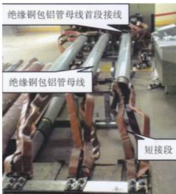
图 2 铜包铝管母线产品图
